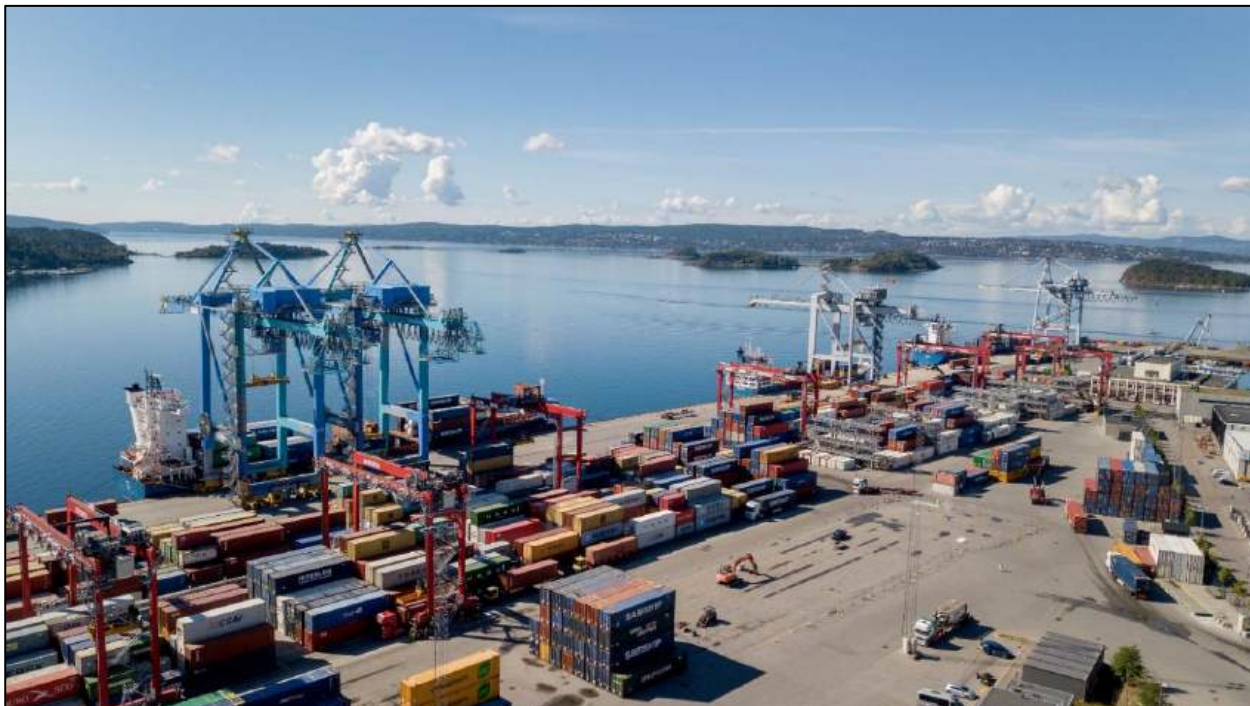
Figur 4: Yilports containerterminal i Oslo hamn (källa: Oslo havn)
